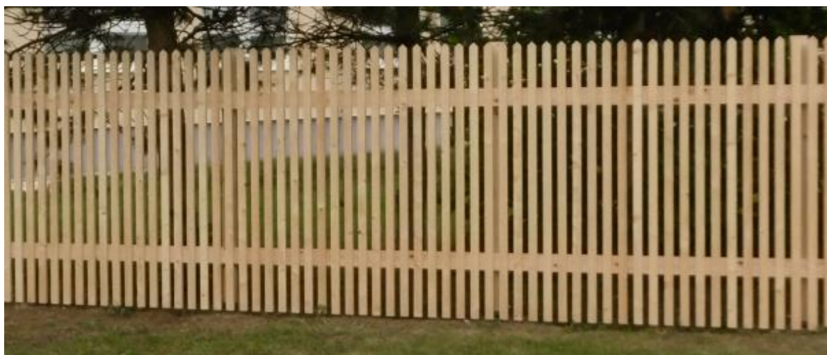
Obrázek č. 9 Realizace-tradiční laťkový plot vysoký 1,8 m.
